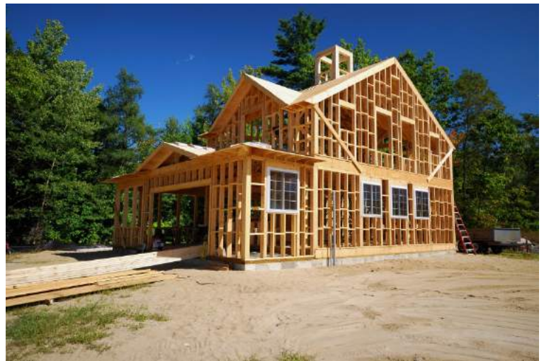
Figure 1. Maison à ossature bois - Source : CBH Constructions Bois
