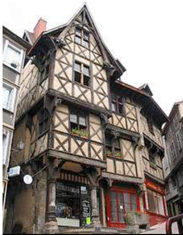
Figure 4. Hôtel Pirou à Thiers : en encorbellements
