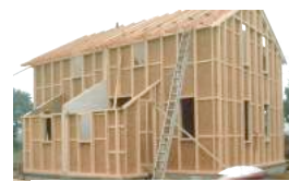
Fig 7 : charpente, ossature et panneaux de
