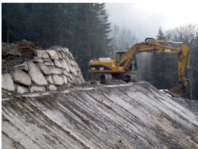
Figure 3. Construction d'une route forestière aux Houches (photo Pognat)
