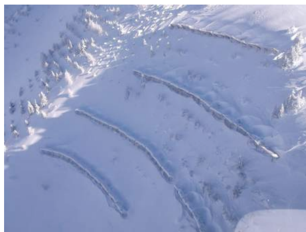
Figure 2. Protection contre les avalanches (Isère) - (photo ONF)
