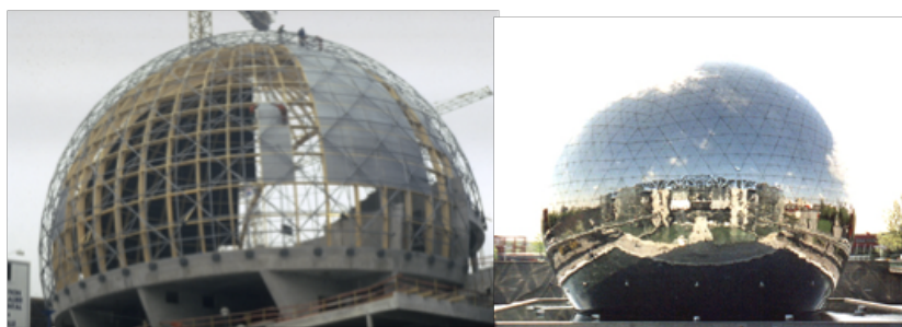
Figure 5. Le cinéma Imax de la Défense avant et après construction
