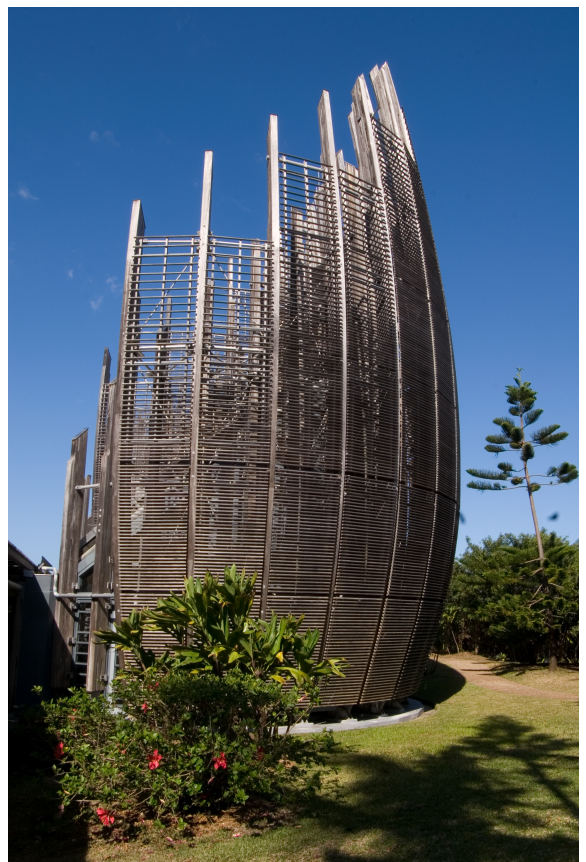
Figure 1. Centre culturel Jean-Marie Tjibaou - Nouméa - Architecte : Renzo Piano - 1998
